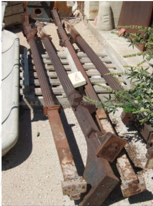
Colonnes anciennes en fonte
