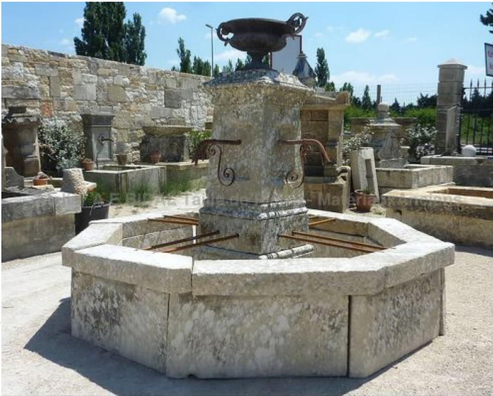
Fontaine centrale avec bassin appareillé, margelle, fût et chapiteau moulurés, surmontée d'une vasque en fonte.
