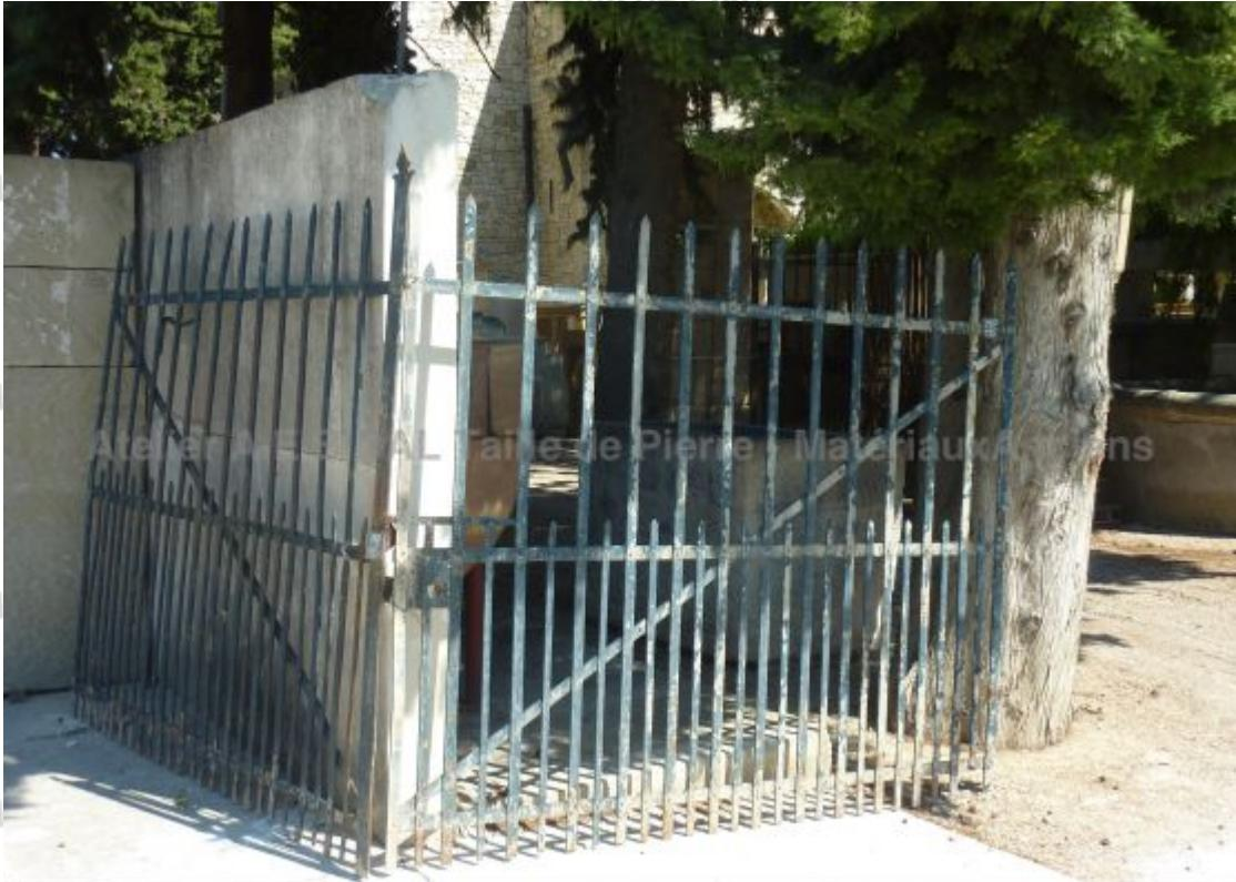
Portail à deux vantaux en fer forgé ajouré. Barreaux et cadre en fer plat. Construction rivetée.
