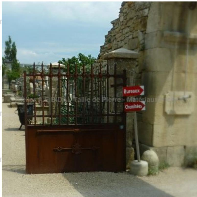
Superbe ancien portail en fer forgé : soubassement tôle, barreaux en fer rond, pointes, fleuronnements et motifs en relief, construction rivetée, gonds de fixation.
