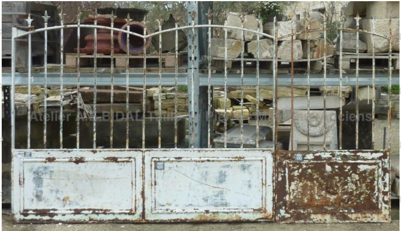
Ancien portail en fer forgé riveté : soubassement en tôle avec motif rectangulaire en relief, barreaux et cadre en fer carré, pointes avec fleurs de lys, gonds de fixation.
