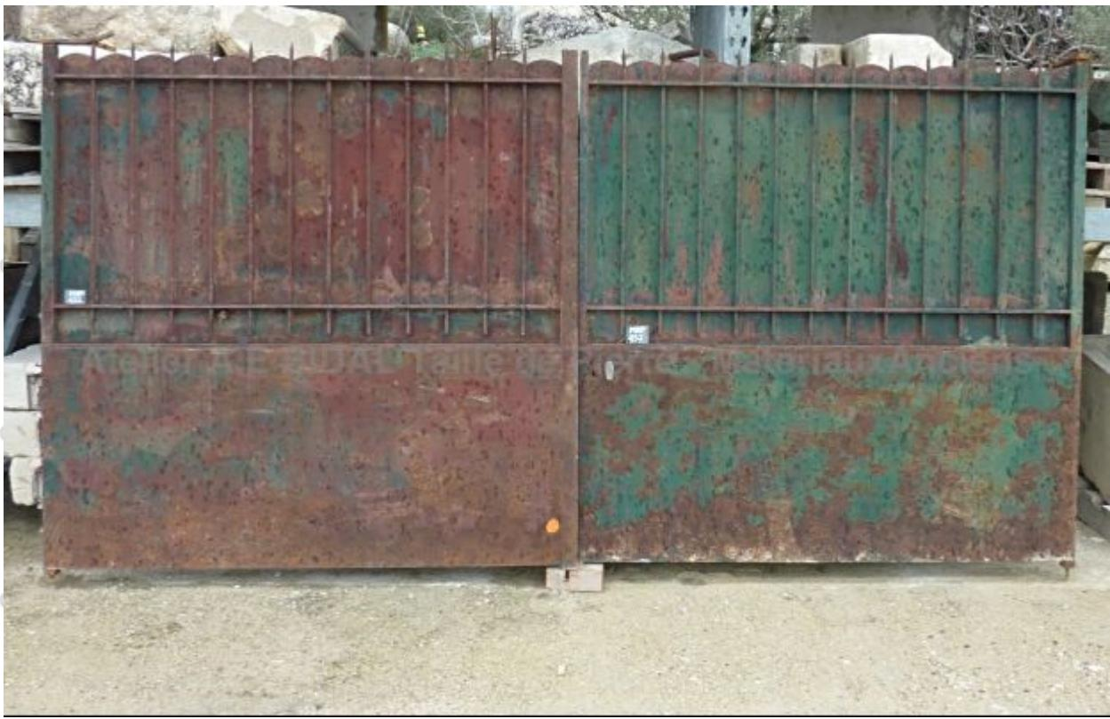
Portail à double vantail en fer forgé. Tolé en plein, cadre en fer plat et barreaux en fer rond terminées par des pointes. Construction rivetée. Vendu avec ses gonds.
