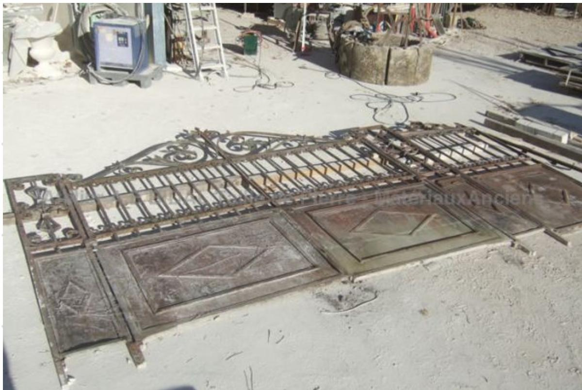
Portail ancien en fer forgé. Soubassement composé de panneaux de tôle avec décors de cadres & losanges se poursuivant sur les dormants, forme "chapeau de gendarme". Beau travail de ferronnerie sur les volutes. Portillon intégré à un dormant.
