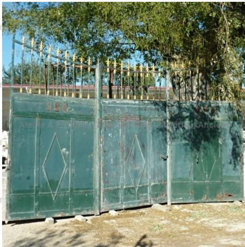
Ce très grand portail ancien (3 mètres de haut par 4,65 mètres de large) est une construction en fer forgé riveté. Il possède trois vantaux dont un muni d'un portillon. Partie basse en tête pleine et barreaux supérieurs en fer fond terminés par des fleurs de lys forgées. Peinture verte avec détails dorés et ferraille rouillée en surface.
