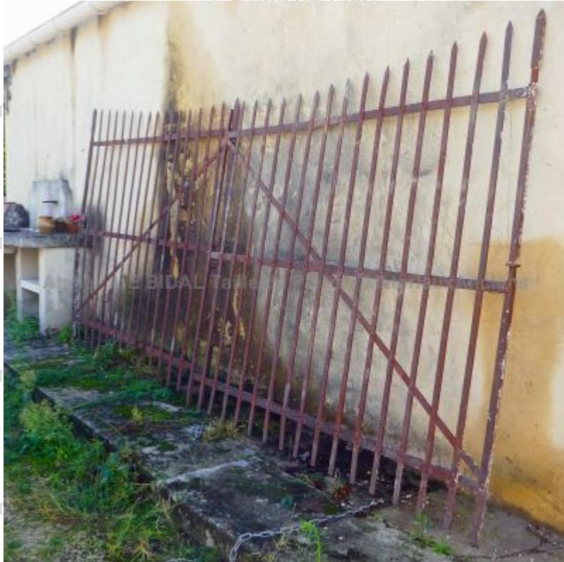
Cet ancien portail à deux vantaux est un large portail de plus de 4 mètres d'ouverture en fer forgé ajouré. Seuls les 2 montants externes sont en fer carré. Toutes les autres barres sont en fer plat. Construction rivetée. Belle patine de rouille en surface.
