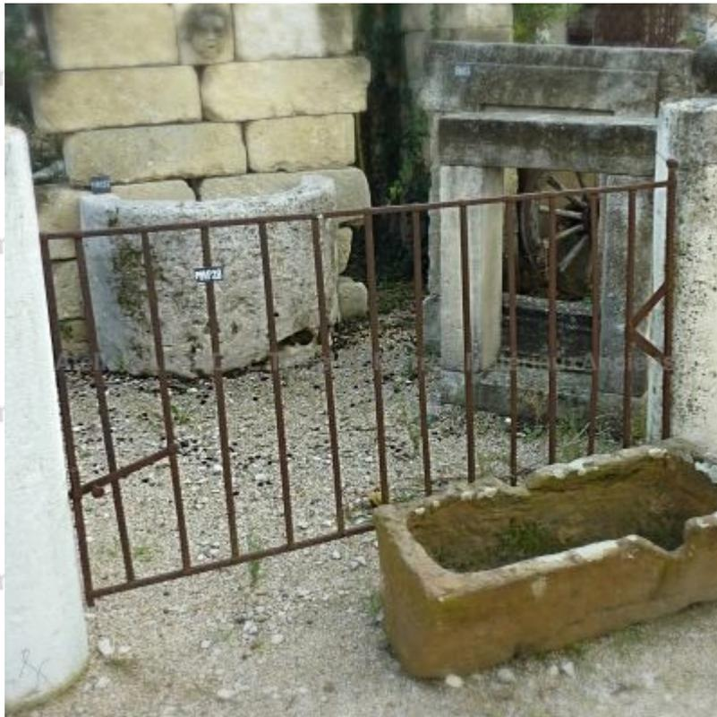
Portillon ajouré en fer forgé à barreaux carrés. Cette petite porte ancienne est toute simple. Construction rivetée, et belle patine naturelle de rouille en surface.
