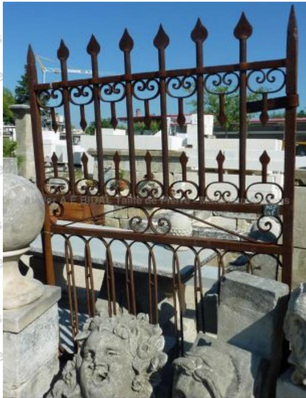
Joli portillon ancien en fer forgé, entièrement ajouré, montants en fer carrés et barreaux en fer ronds terminés par des fers de lance. Nombreux décors de volutes. Construction rivetée, belle patine de rouille en surface.
