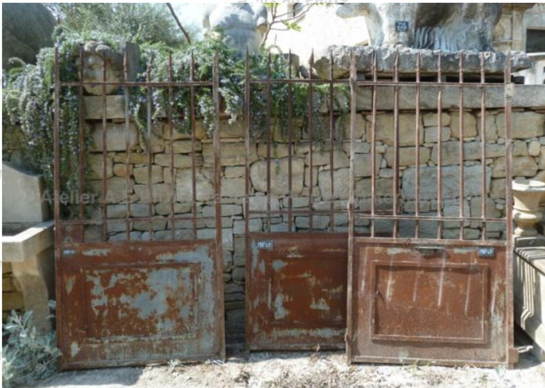
Portail ancien riveté, en fer forgé, à trois vantaux. Semi ajouré, le soubassement est composé de panneaux de tôle avec décor de cadre en fer carré, les barreaux en fer rond sont terminés par des fers de lance.
