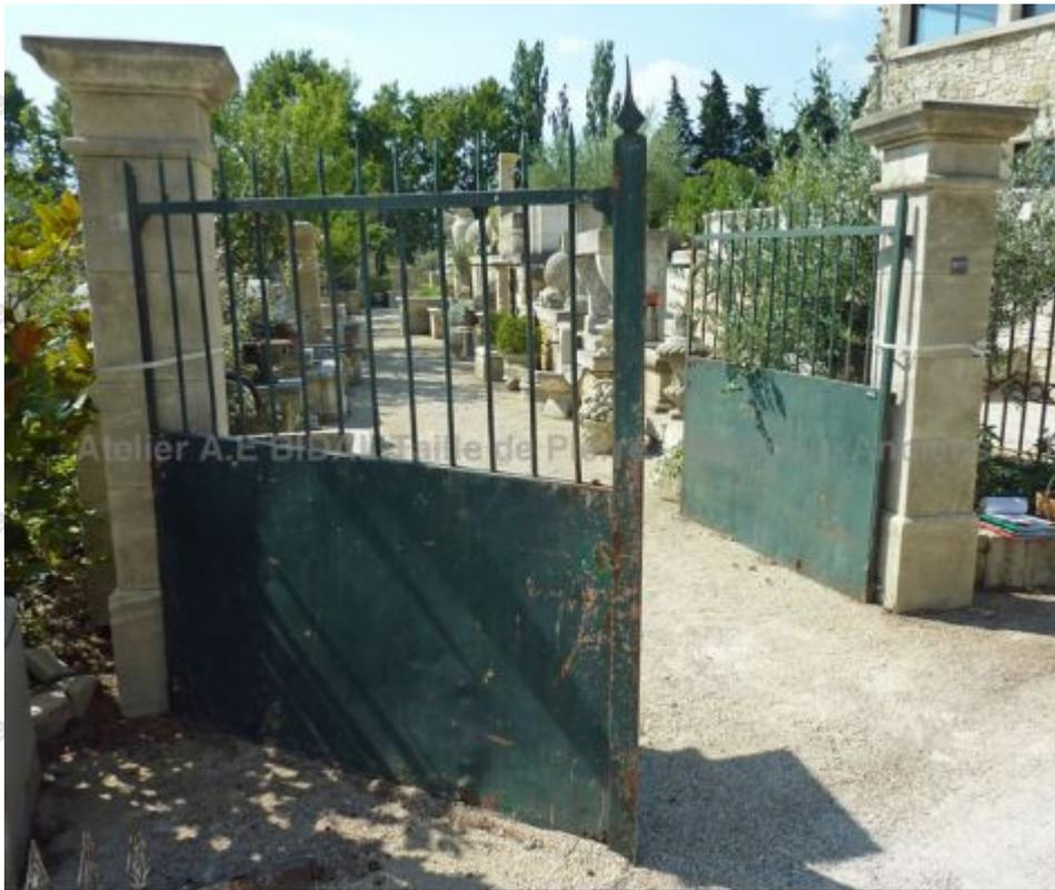
Joli portail ancien en fer forgé à double vantaux semi ajourés. Soubassement composé de panneaux de tôle, cadre en fer carré et barreaux en fer rond ornés de pointes. Construction rivetée. Belle patine de rouille en surface.
