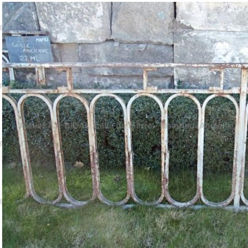
Rambardes anciennes en fonte. Ce garde-corps présente des ovales dans sa partie basse et des rectangles dans sa partie haute. Ancien passage de pont.
