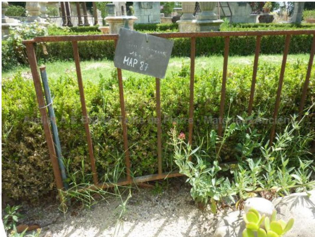
Rambardes anciennes en fer forgé simple et ajouré. Ce petit garde-corps possède un cadre rectangulaire en fer carré et des barreaux en fer rond.
